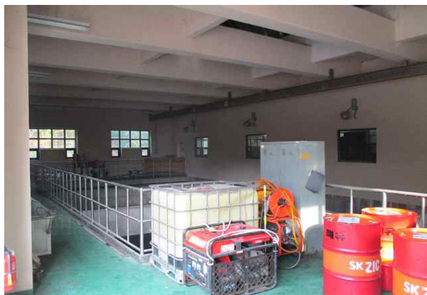
1층 내부 전경
