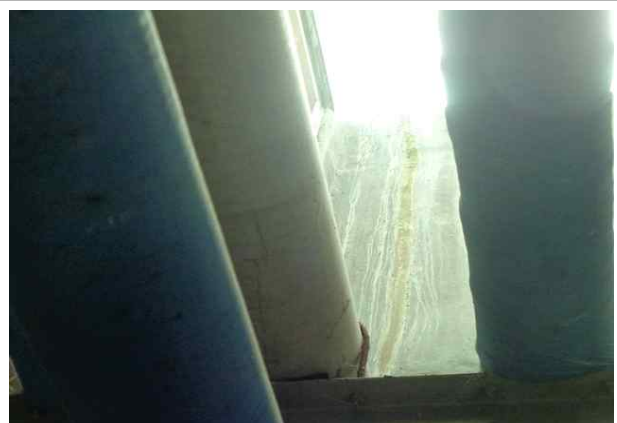
A-Line 천장 박리 및 박락 (A=0.1m×3.0m)
