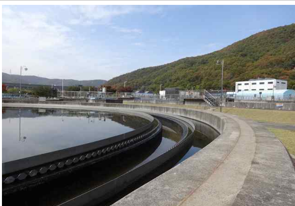
2지 내부 벽체 균열 및 백태 (L=1.0m, 36EA)
