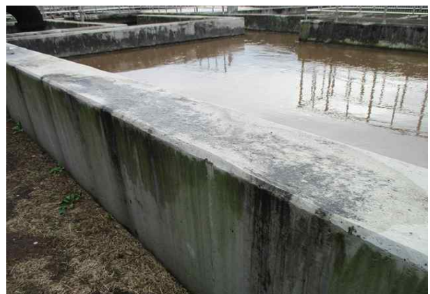
선택조 및 혐기성조 벽체 오염 및 도장박리 (A=2.0m×1.0m)
