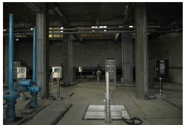
지하층 내부 전경
