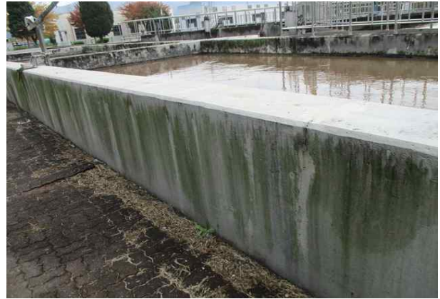
선택조 및 혐기성조 벽체 균열 및 백태 (CW=0.1mm L=1.0m, 13EA)
