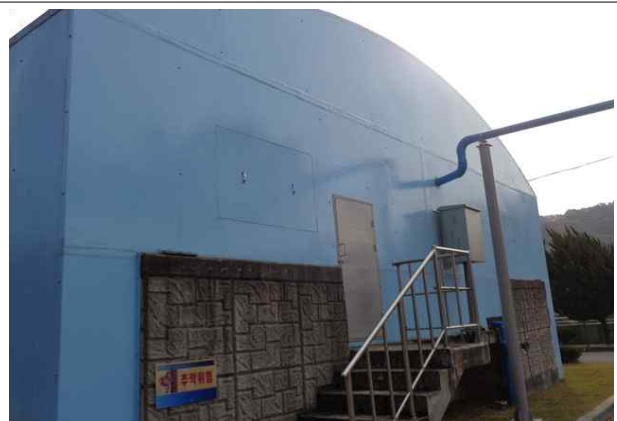
FRP 지붕 증축 양호
